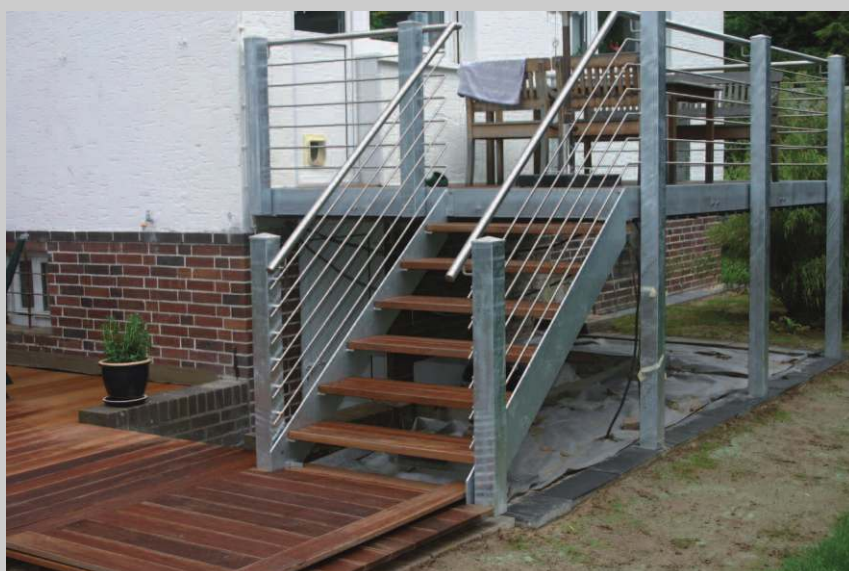
Pfosten verzinkt- Handlauf und Geländer in Edelstahl
